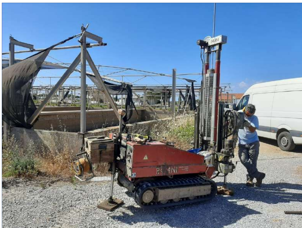
Figura 2: Postazione prova penetrometrica DIN 6
