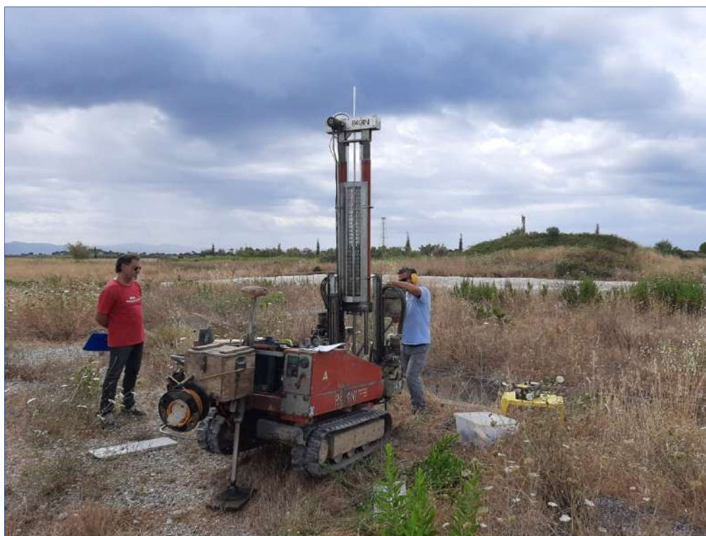
Figura 1: Postazione prova penetrometrica DIN 2
