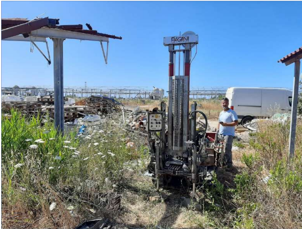
Figura 3: Postazione prova penetrometrica DIN 8
