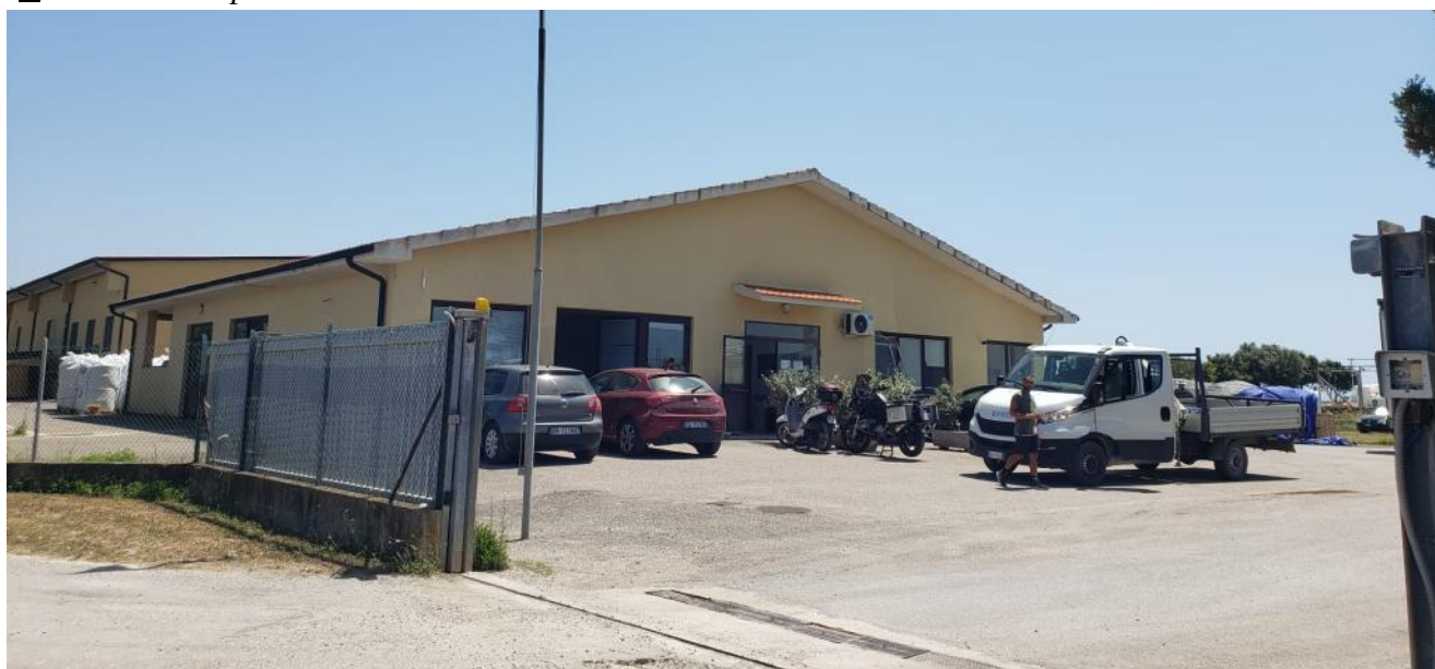
Accesso all' impianto IGF
