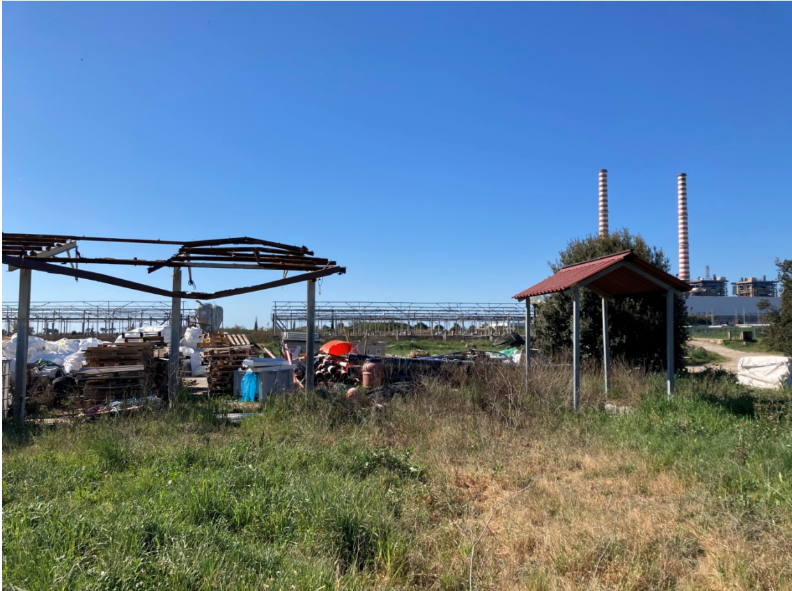
foto 21: costruzioni minori - deposito gasolio agricolo (rif. 28) - vista da nord-ovest
