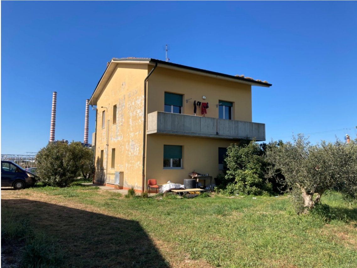
foto 1: foresteria (rif. 1) - vista da nord-est
