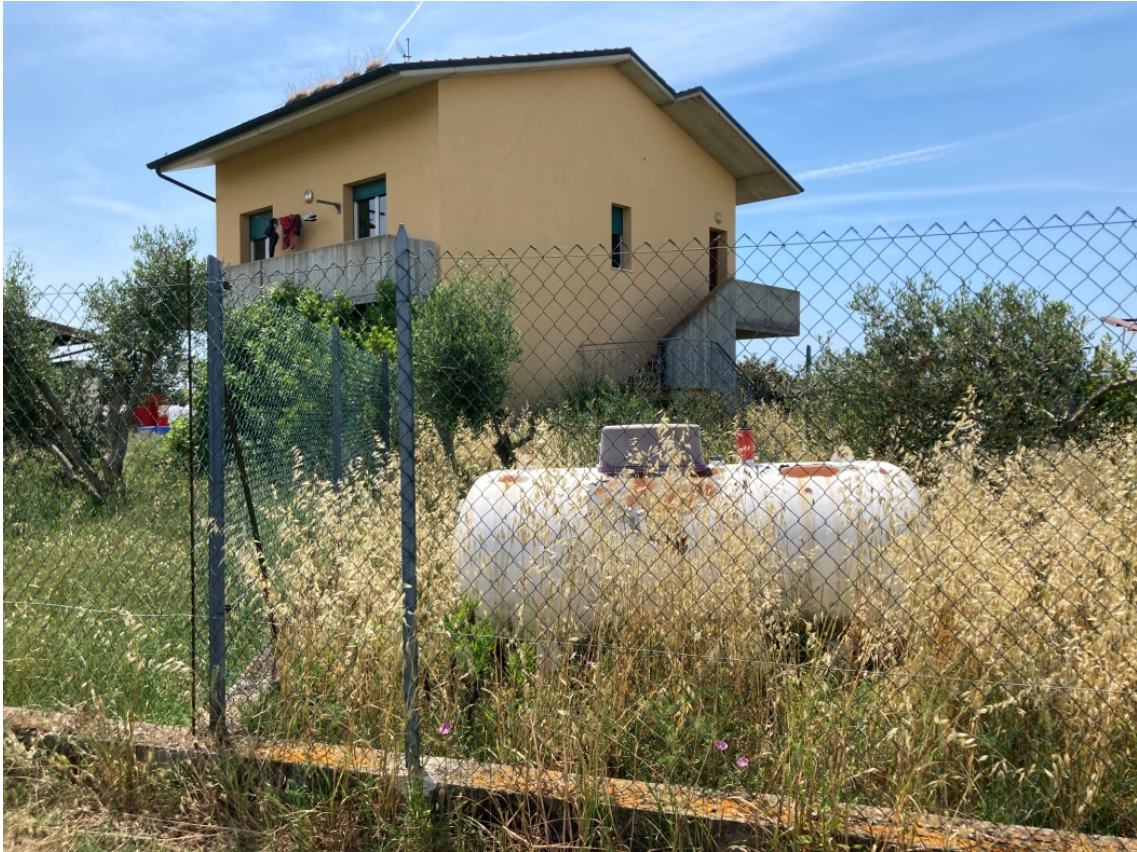
foto 15: costruzioni minori - deposito GPL (rif. 9) - vista da nord-ovest
