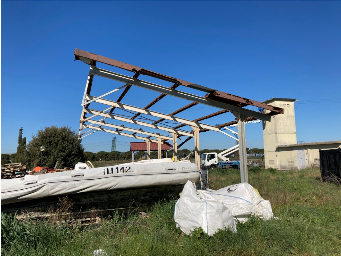
foto 9: tettoia (rif. 5) - vista da est
