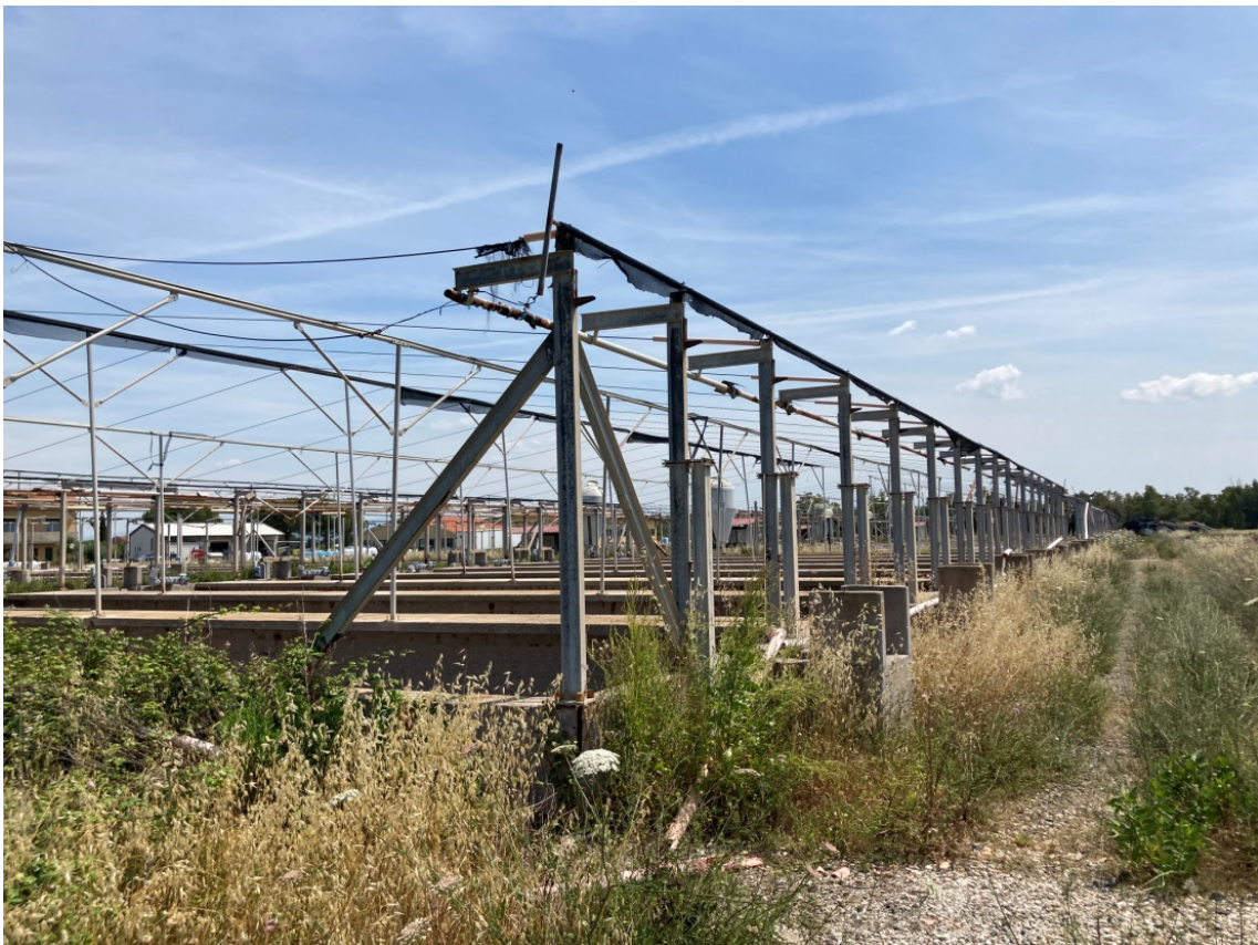
foto 12: vasche di allevamento in manutenzione (rif. 7) - vista da sud-ovest
