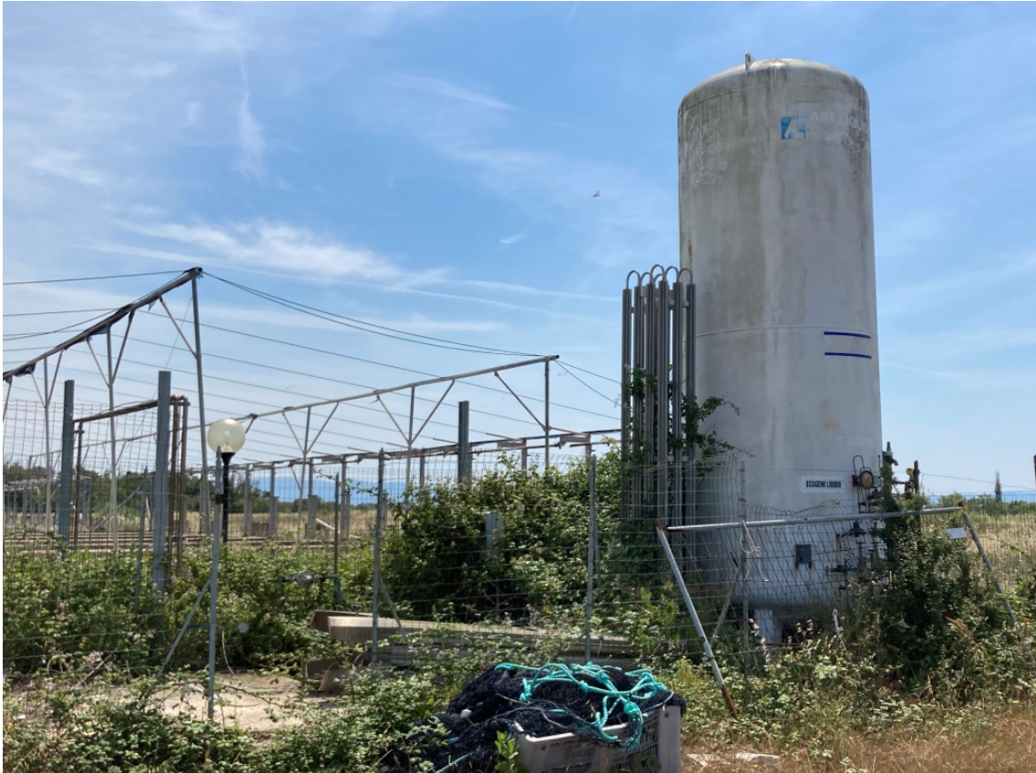
foto 17: costruzioni minori - deposito di ossigeno (rif. 12) - vista da nord-ovest
