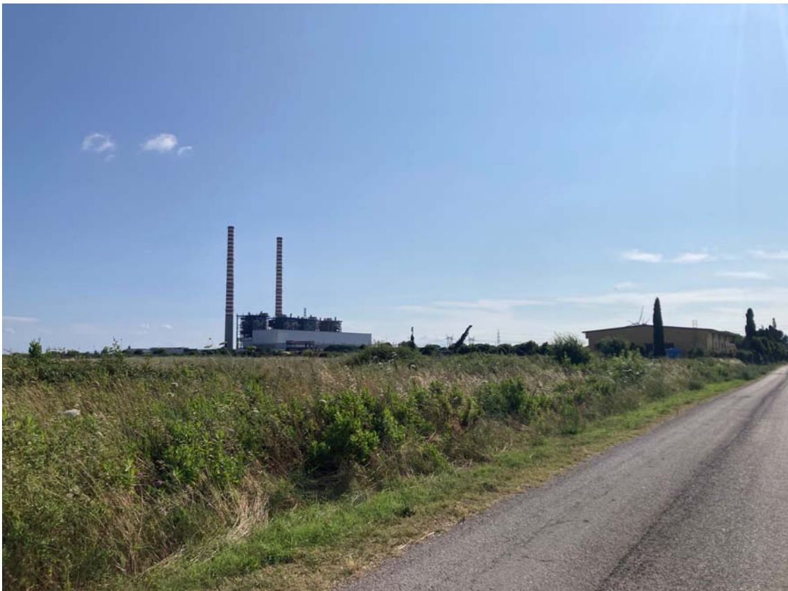
Foto 4: vista del compendio aziendale “3” da est lungo la strada poderale di accesso
