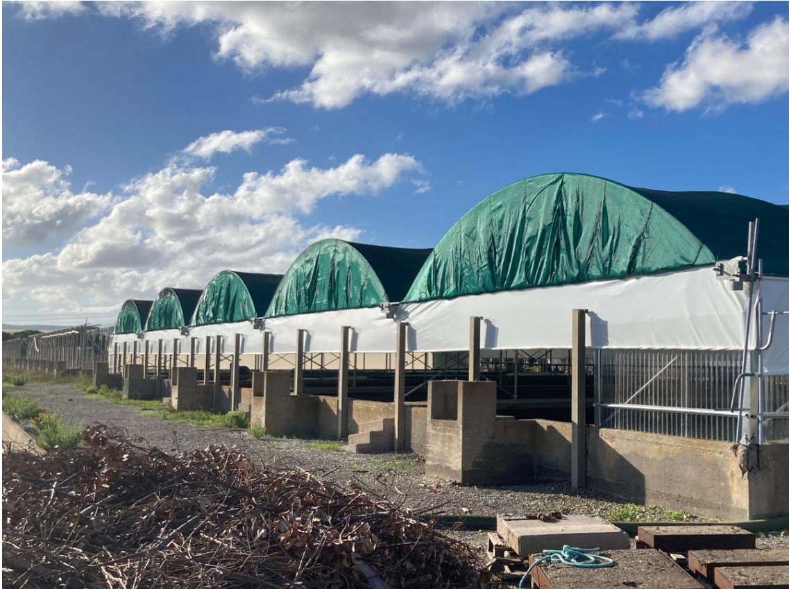
foto 13: vasche di allevamento attive (rif. 7) - vista da sud-est
