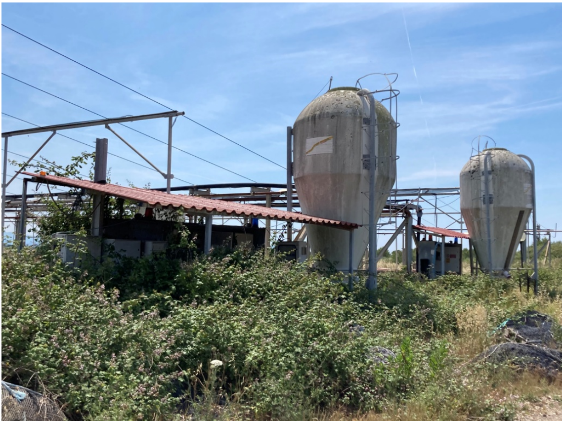
foto 16: costruzioni minori - deposito mangime (rif. 10) e tettoia quadri elettrici (rif. 11) - vista da nord-ovest
