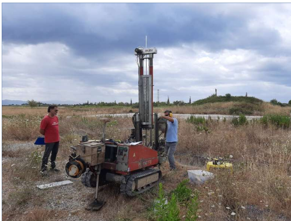
Figura 1: Postazione prova penetrometrica DIN 2
