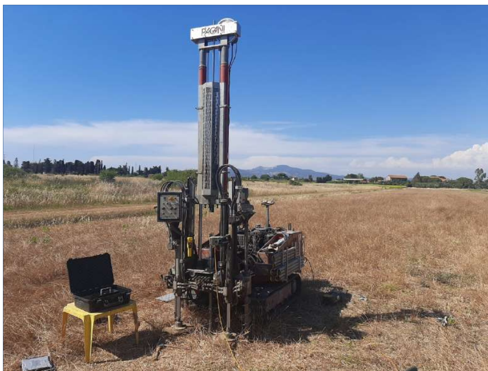
Figura 3: Postazione prova penetrometrica P15
