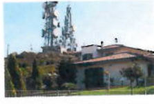
Nella zona della Tolla sono previsti impianti sportivi
