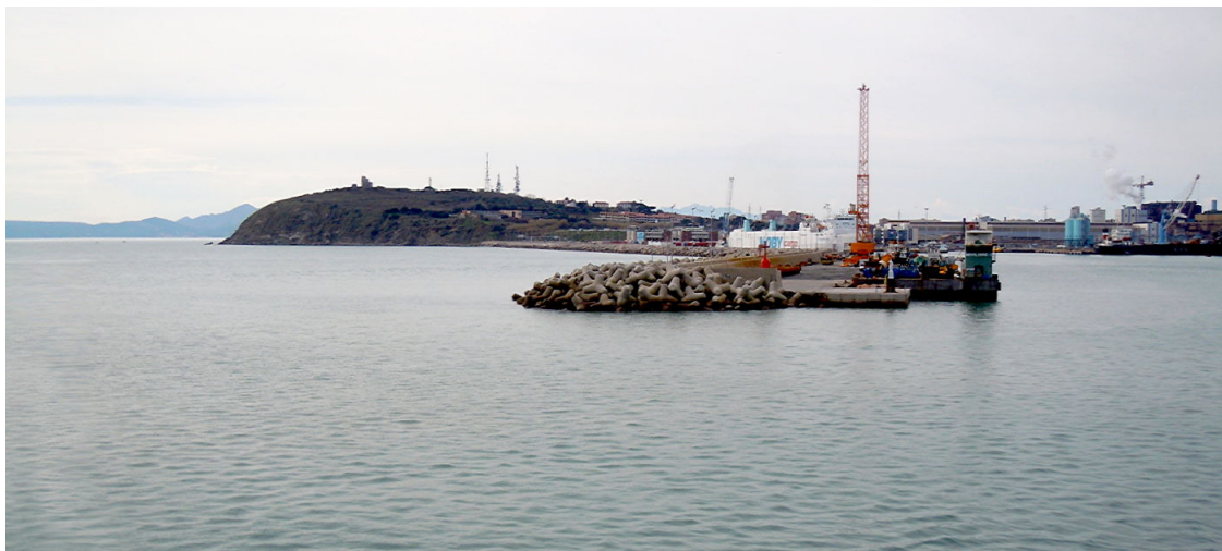
figura 6: foto dell'area di intervento ripresa entrando in porto
