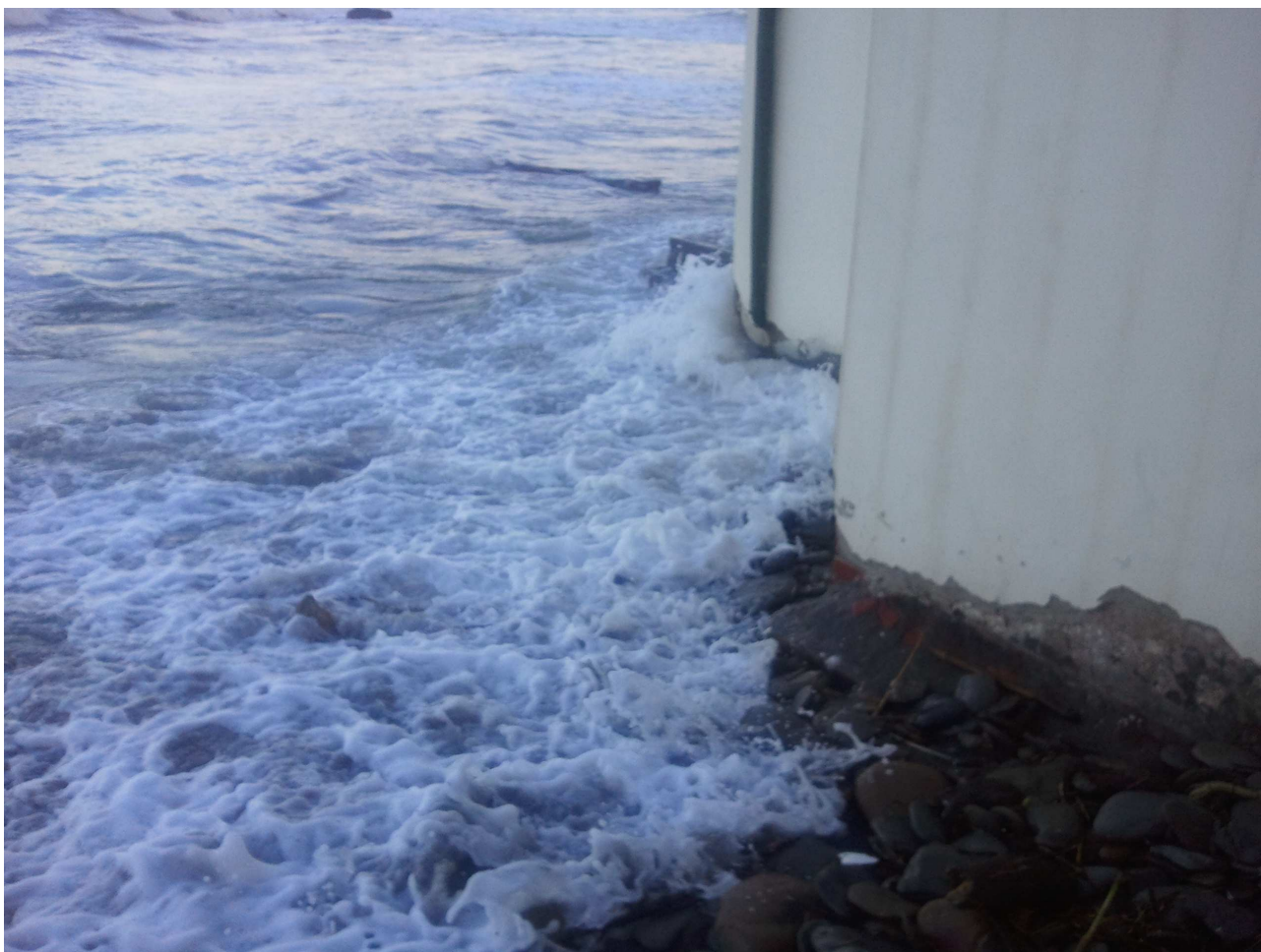
Figura 3 – Azione del mare sullo spigolo nord del fabbricato posto in aderenza al lato nord della torre
