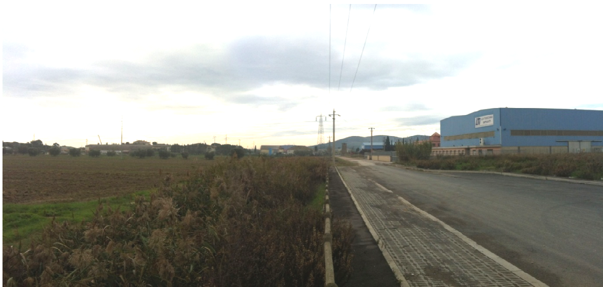
7. Aree già urbanizzate all'interno del PIP e lotti già assegnati, a sinistra, destinati a depositi
