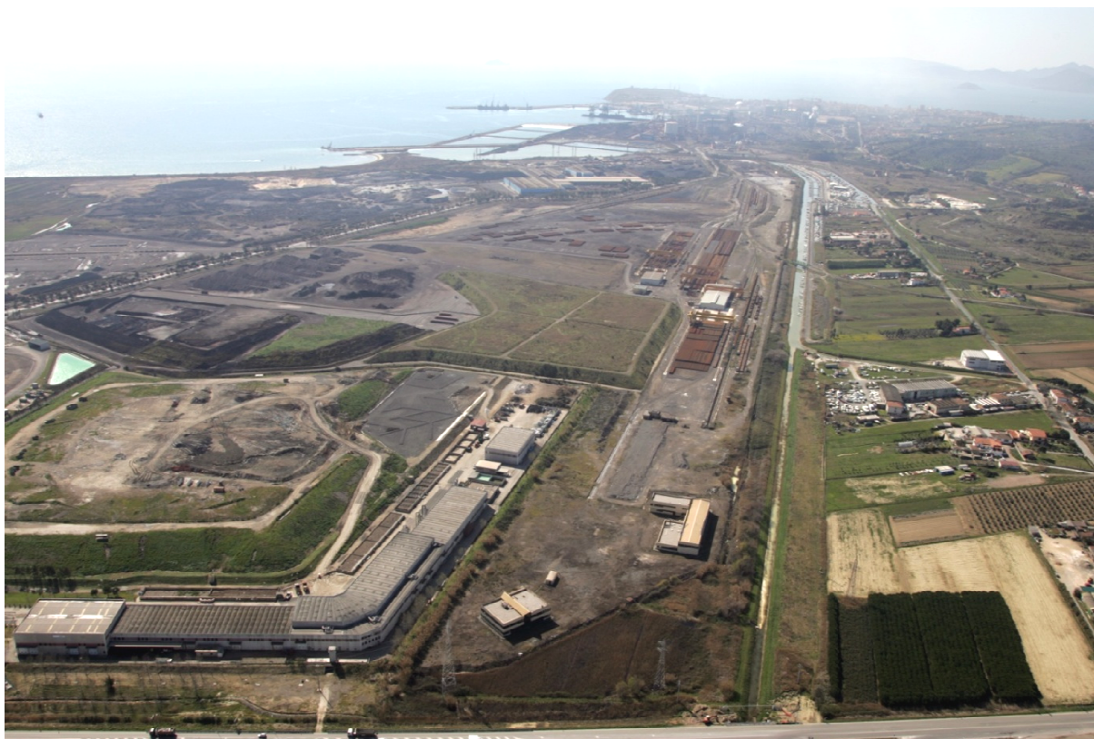
4. Assetto infrastrutturale e presenza antropica a sud della Strada Base Geodetica
