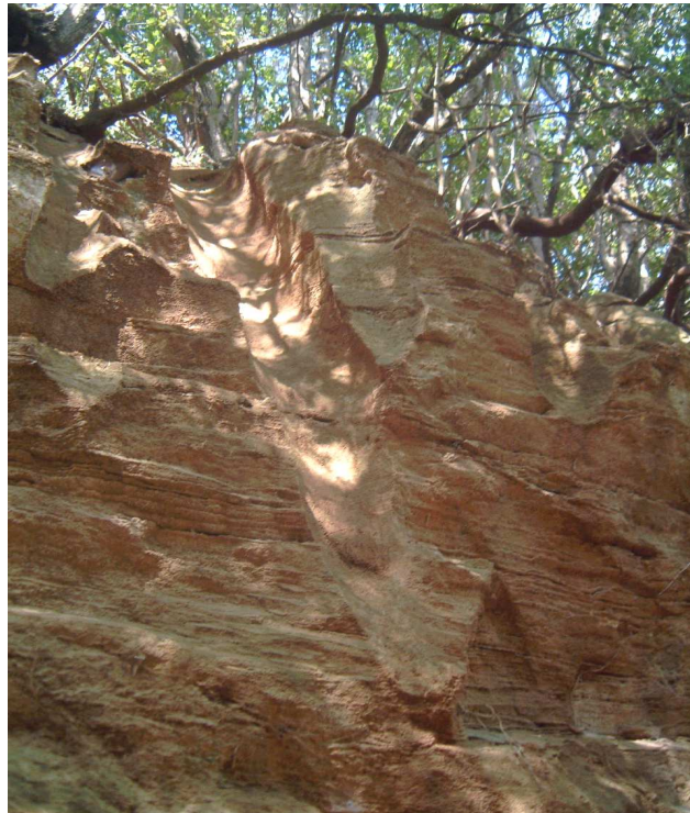
Figura 8 – Forme di erosione dovuta al passaggio di acqua
