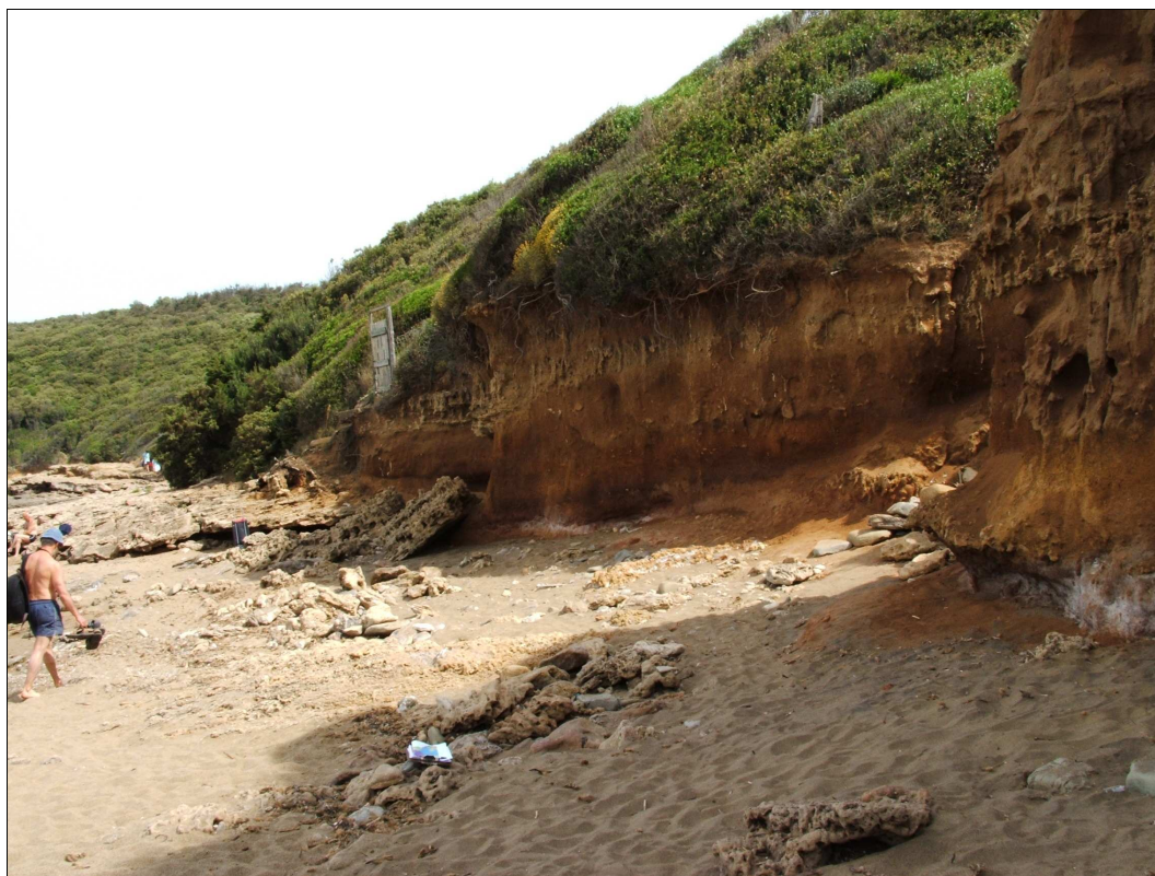
Foto. 28: L'erosione in atto lungo la falesia, con crollo di porzioni di Panchina pleistocenica sulla spiaggia attuale
