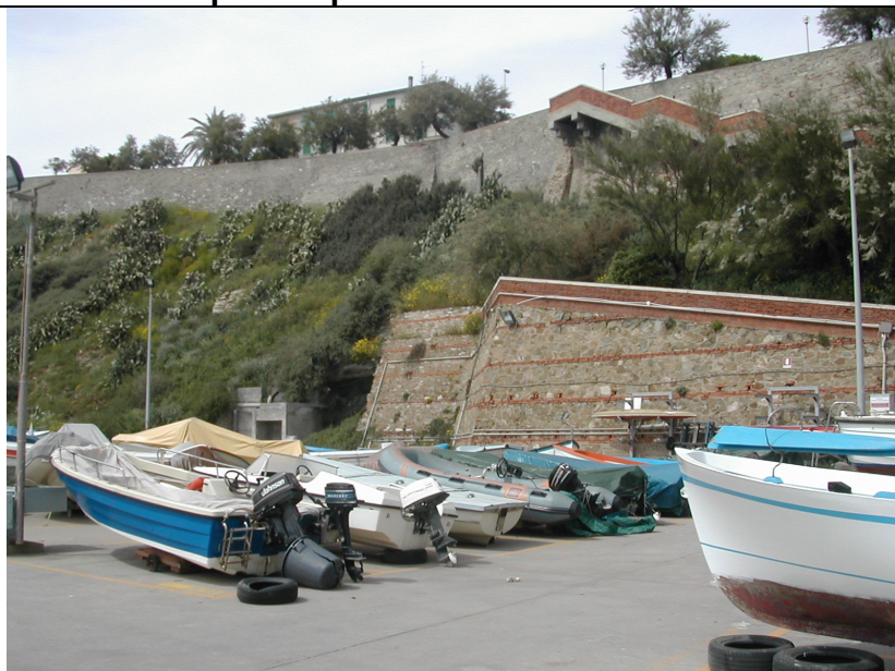
Vista su muro di contenimento percorso pedonale.
