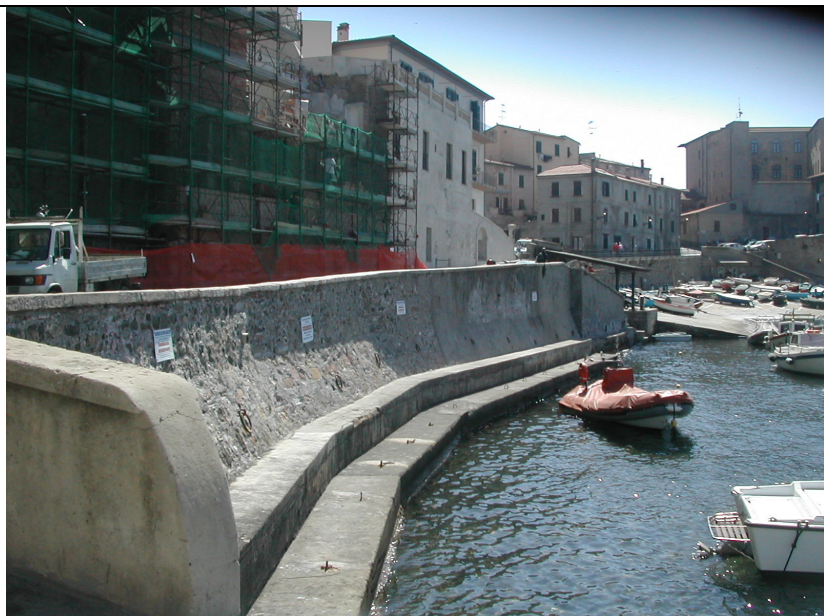
Vista via di Marina
