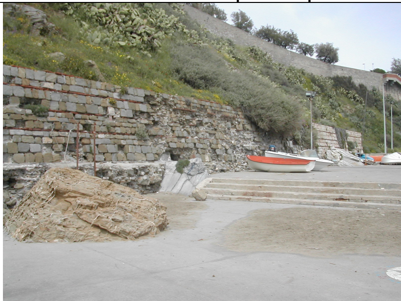
Muro di contenimento lato ovest.
