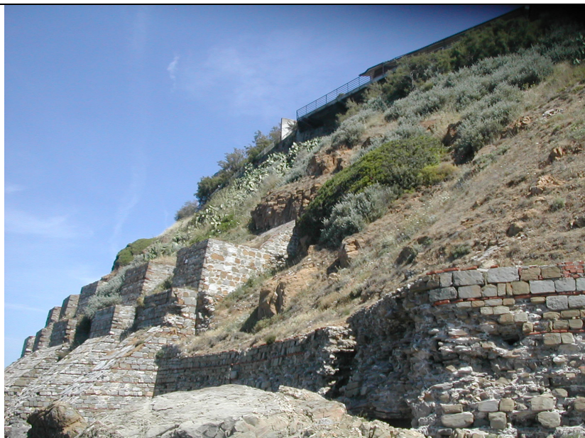
Vista sui contrafforti di contenimento.
