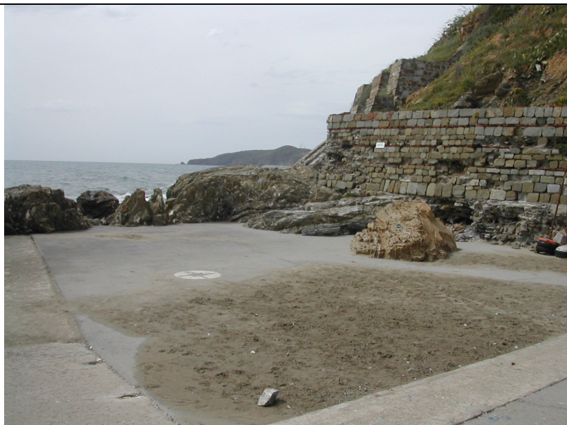
Vista lato ovest
