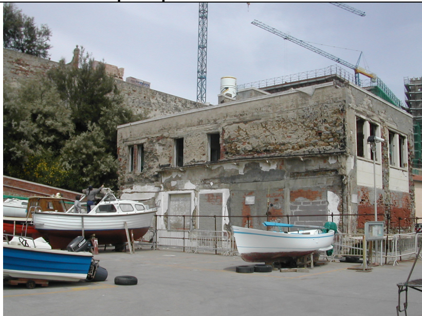
Vista facciata tergale lato ovest
