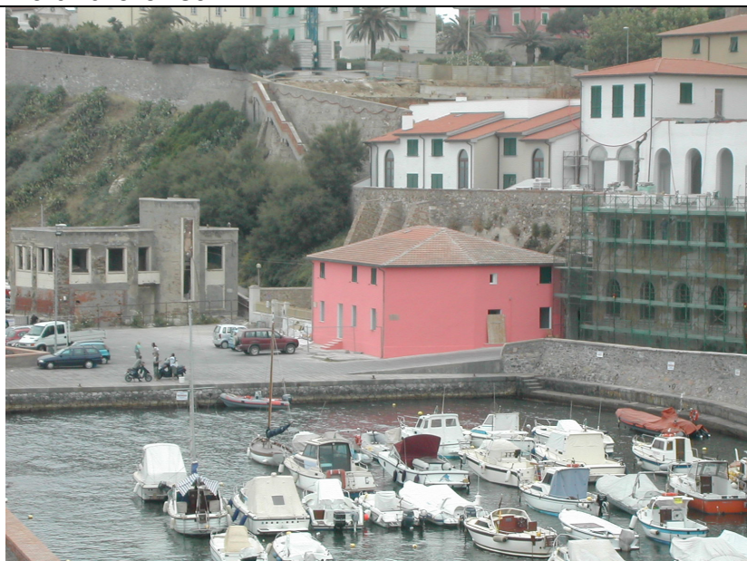
Vista lato sud-est
