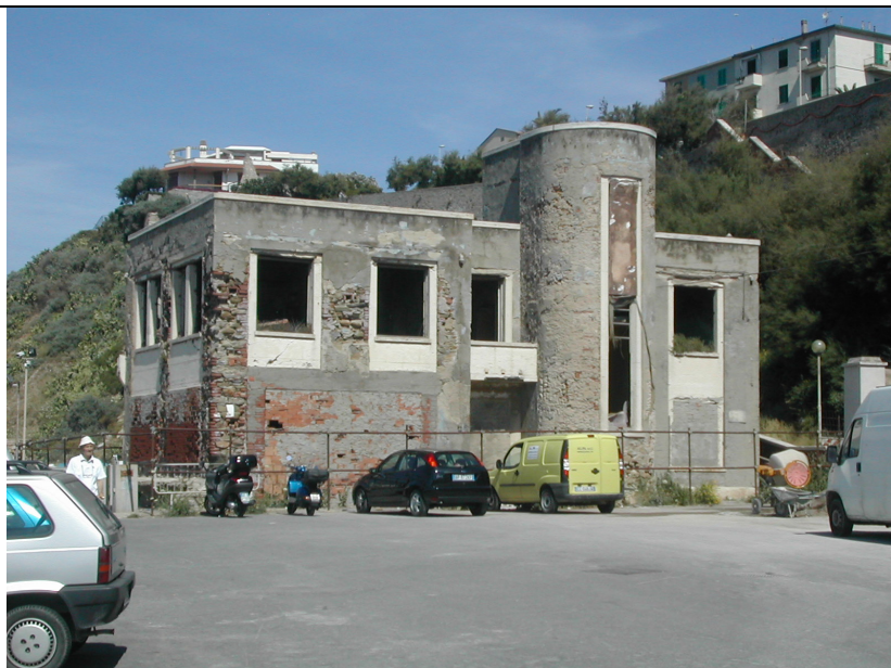
Vista facciata principale lato est
