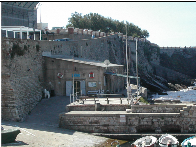
Vista facciata laterale lato nord
