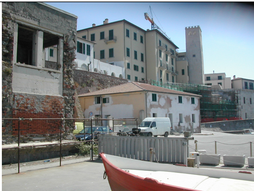
Vista lato ovest
