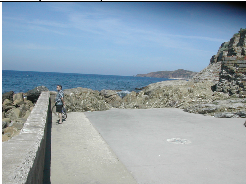
Vista sul lato ovest del piazzale
