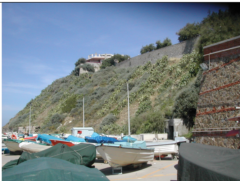
Vista della ripa dal piazzale.
