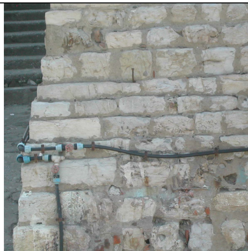
02- muro di contenimento piazzetta del mare in bozze di pietra faccia vista.
