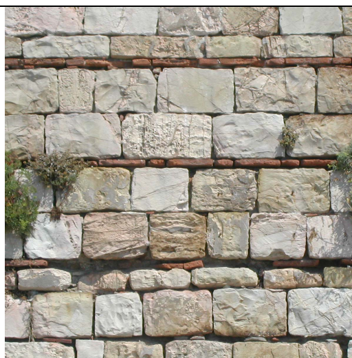
15- Muro di contenimento ripa sotto Cittadella in pietra faccia-vista e ricorsi orizzontali in laterizio
