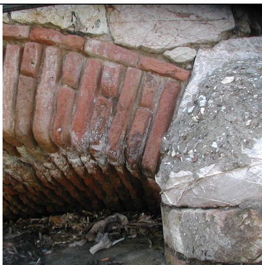
05- particolare cateratte occluse, arco in mattoni e muro in pietra.
