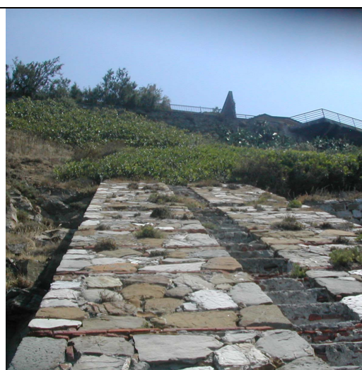
04- Contrafforti sotto Cittadella particolare sulle cento scalinate in conci di pietra e ricorsi di mattoni.
