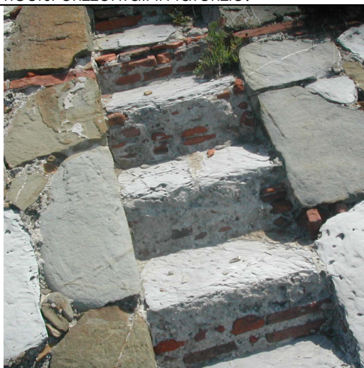
09- Contrafforti a protezione della ripa di Cittadella in conci di pietra e ricorsi orizzontali in laterizio.
