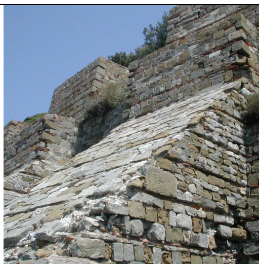
09- Contrafforti a protezione della ripa di Cittadella in conci di pietra e ricorsi orizzontali in laterizio.
