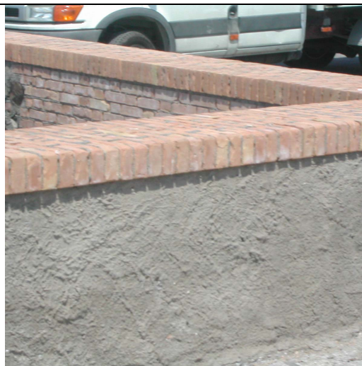
13- Muro di protezione molo ovest cimasa in mattoni faccia-vista..
