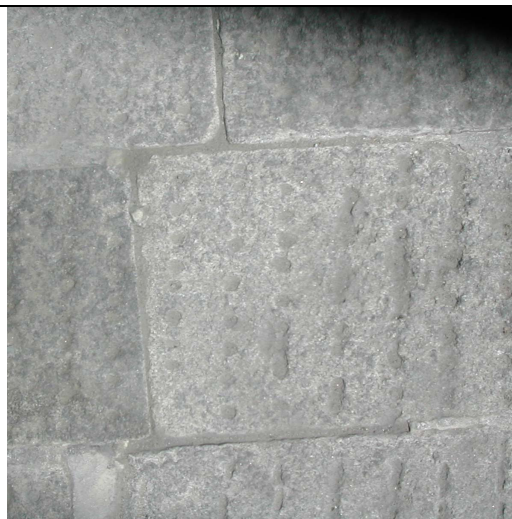
07- particolare pavimentazione lungo via Mazzini e molo Ovest in lastre di pietra locale.
