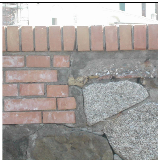
06- particolare muro di contenimento molo ovest in mattoni e pietra faccia vista.
