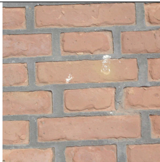
14- Cimasa in mattoni faccia-vista muro di contenimento scogliera molo ovest.
