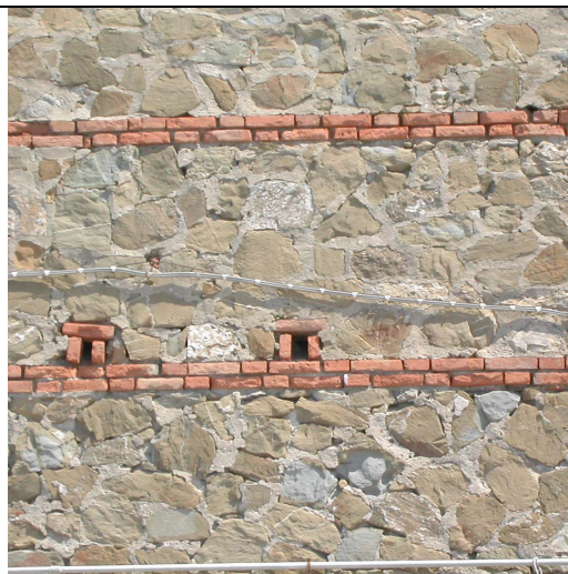
01- muro di contenimento percorso pedonale di accesso al piazzale-pietra con ricorsi in mattoni.
