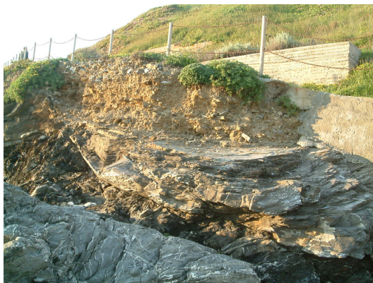
Foto 19. – Placca detritica su cui si appoggia la strada di accesso al mare
