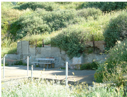
Foto 20 – Parete verticale con funzione di muro a retta, caratterizzato da varie tecniche costruttive (Piazzola 3 quota 5.0 m.s.l.m.)
