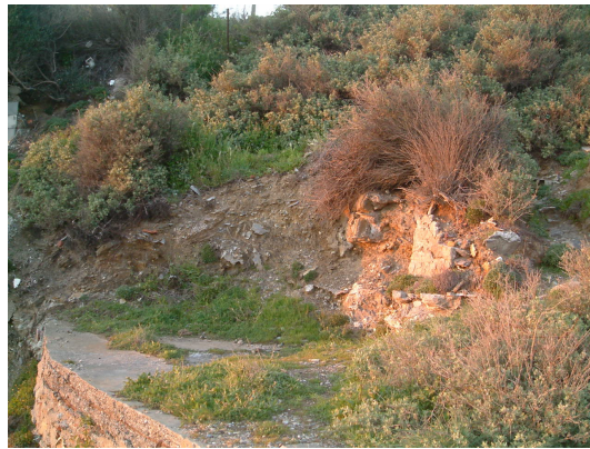
Foto 18 – Piazzola a quota 12.0 m senza il muro di contenimento
