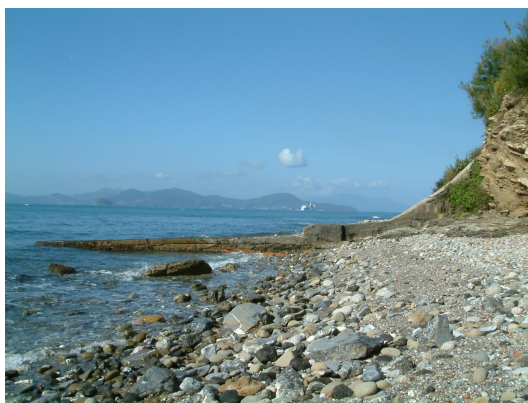
Foto 13 – manufatto in cemento, ex scarico dei reflui dei Macelli
