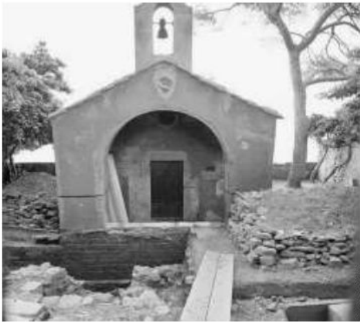
SULLA SPIAGGIA DI BARATTI
