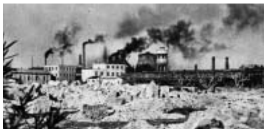
SOPRA LE ROVINE TORNANO A FUMARE LE CIMINIERE: ANCORA UNA VOLTA LA VITA HA VINTO LA MORTE!
