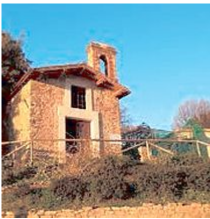
RESTAURATA La chiesetta di Santa Lucia sorge accanto al Calidario
