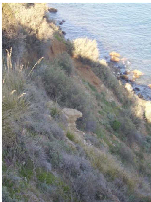
Foto 5: panoramica della parete costiera. Si osservi la zona di distacco (porzioni prive di vegetazione) della coltre detritica lungo la parete.
