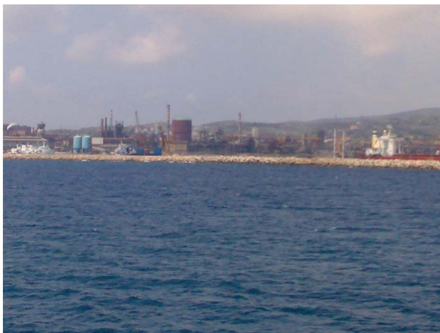
Foto 3: panoramica del porto industriale
