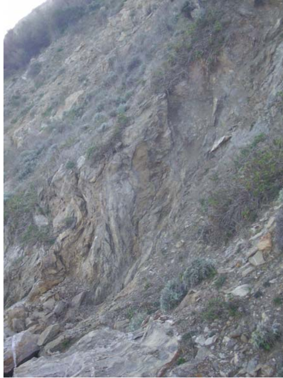
Foto 6: panoramica dell'affioramento del substrato roccioso.
