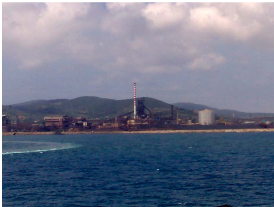
Foto 2: panoramica del porto industriale
